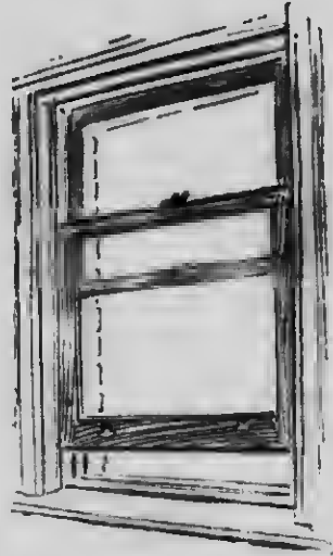
FIG. 78.—Fenêtre à guillotine.
